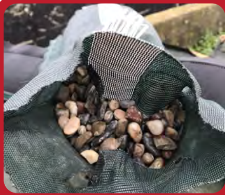
Remplir avec du gravier
