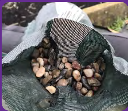
Remplir avec du gravier
